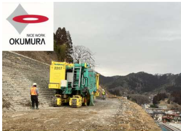
供用線、住宅地付近での近接施工(220SM)
